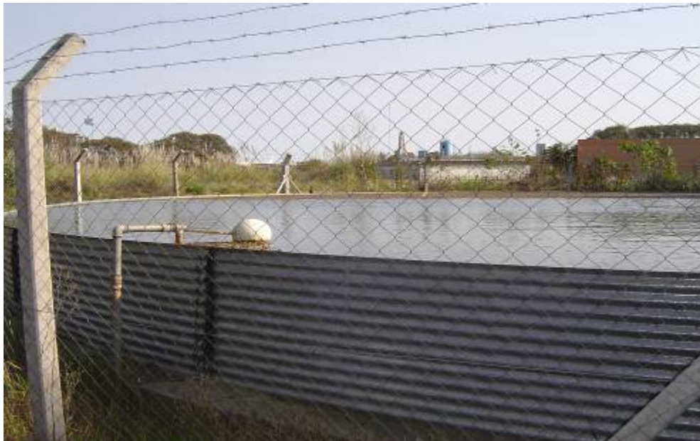
FOTO 20: Tanque de reserva. Instalación para la Prevención de Incendios – Zona Viamonte
