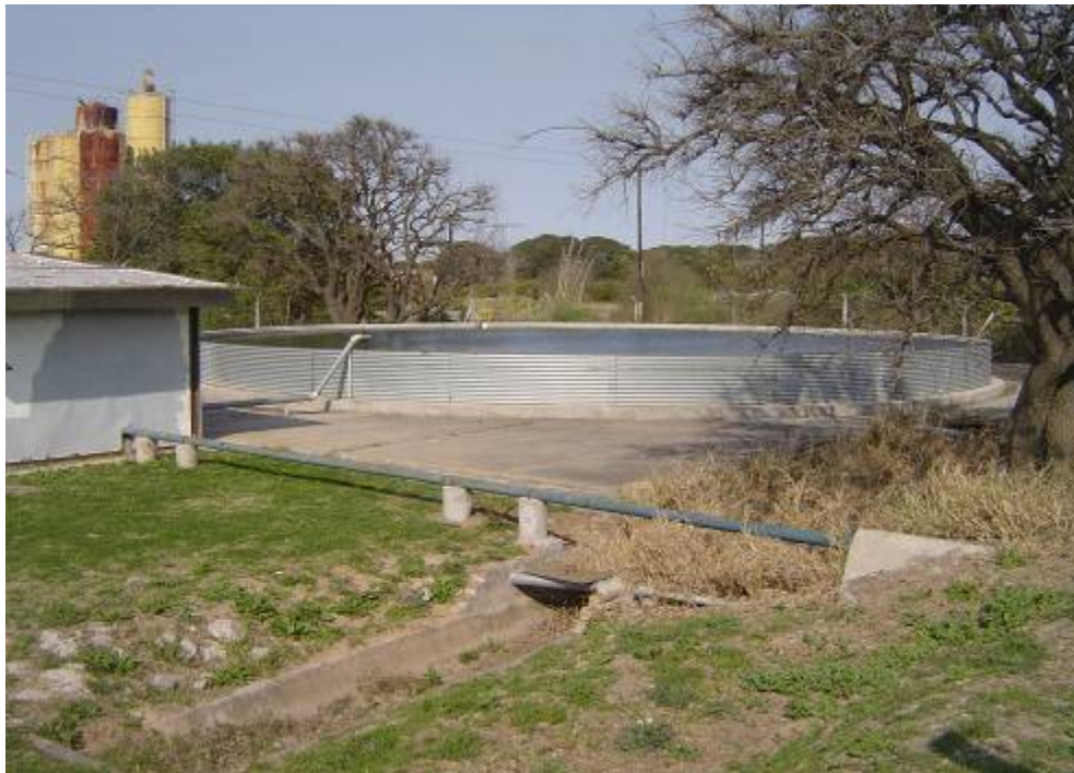
FOTO 22: Tanque de reserva. Instalación para la Prevención de Incendios – Zona Brasil
